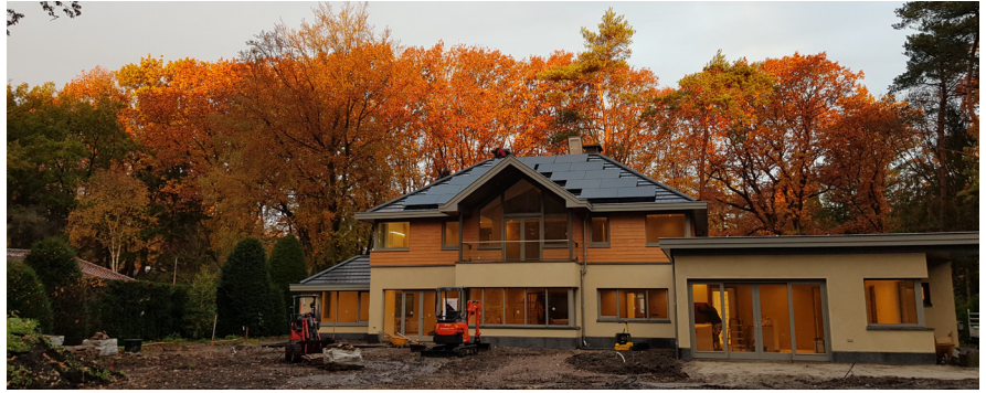
Bouw van de woning
